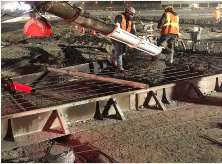
Concrete pour in the Phase I area
